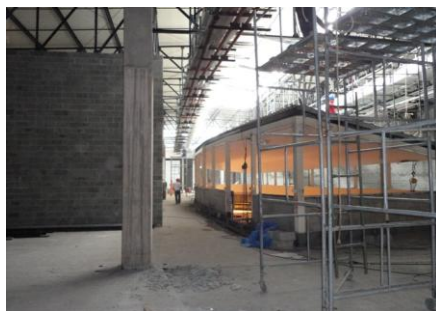
Obras de Expans o do Campo Limpo
