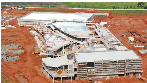
Obras do Uberlândia Shopping
