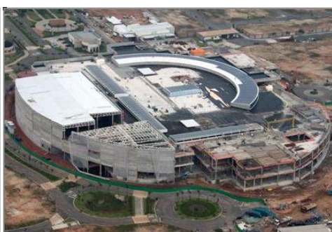
Foto das obras no 1T11
