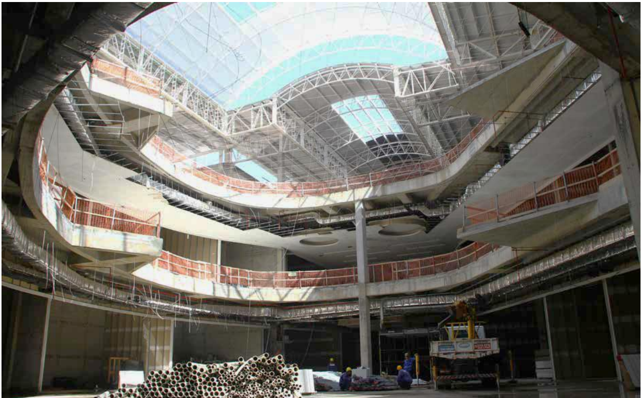
Parque Shopping Maceió – construção (Junho 2013)
