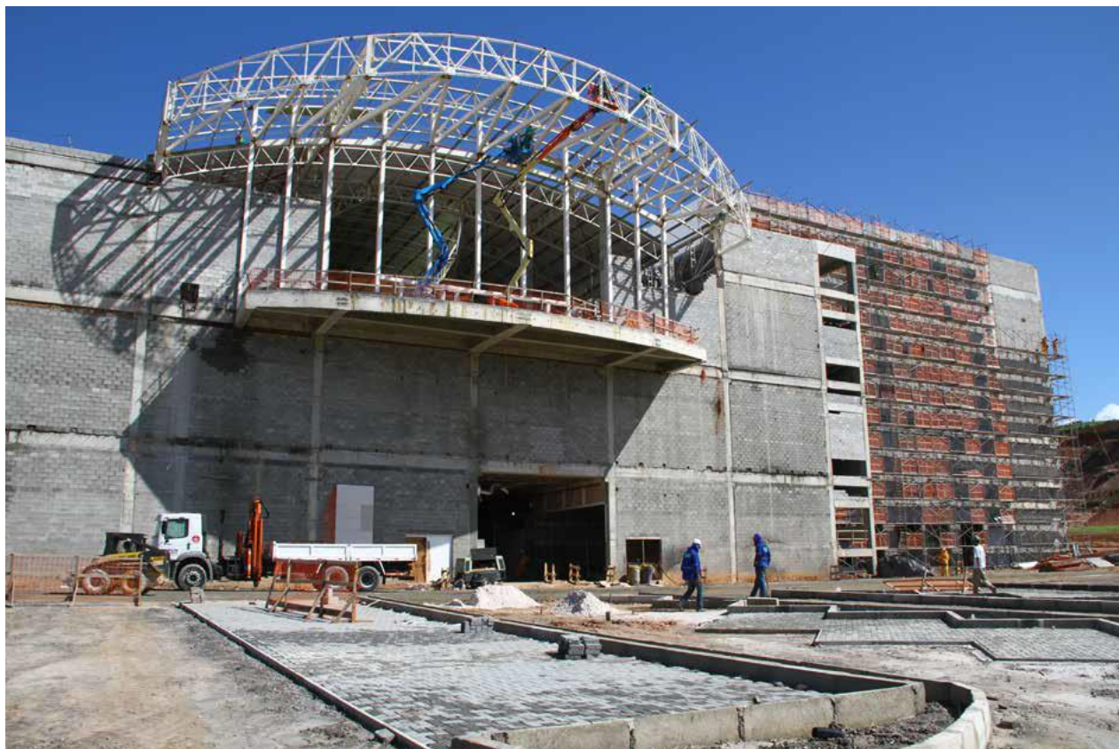
Parque Shopping Maceió – construção (Junho 2013)
