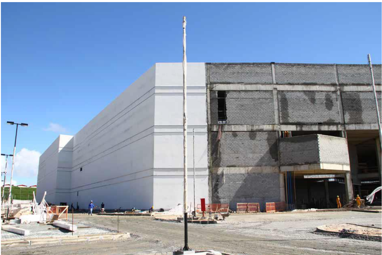
Parque Shopping Maceió – construção (Junho 2013)
