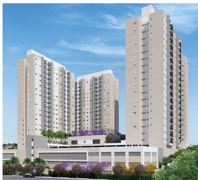
Vista Geral - Projeto Prime House Bussocaba
