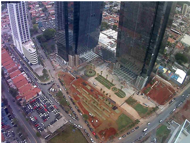
Foto Área de Acesso - EZ Towers em 05 de novembro de 2014
