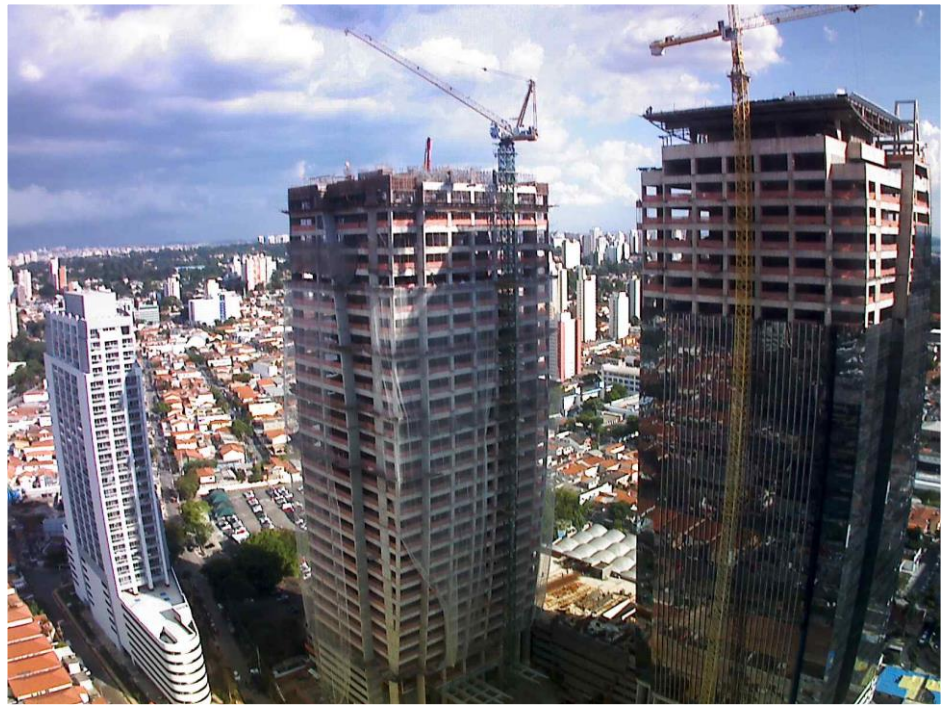
Foto do Canteiro de Obra EZ Towers em 17 de março de 2014
