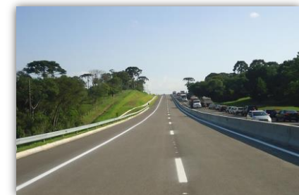
Duplicação da BR-116/PR (Autopista Planalto Sul)
