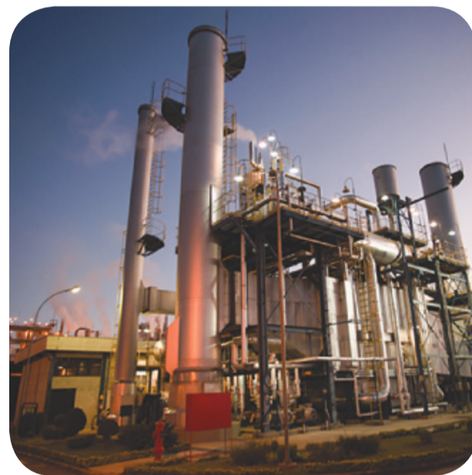
Usina de cogeração Balsa Nova - PR
