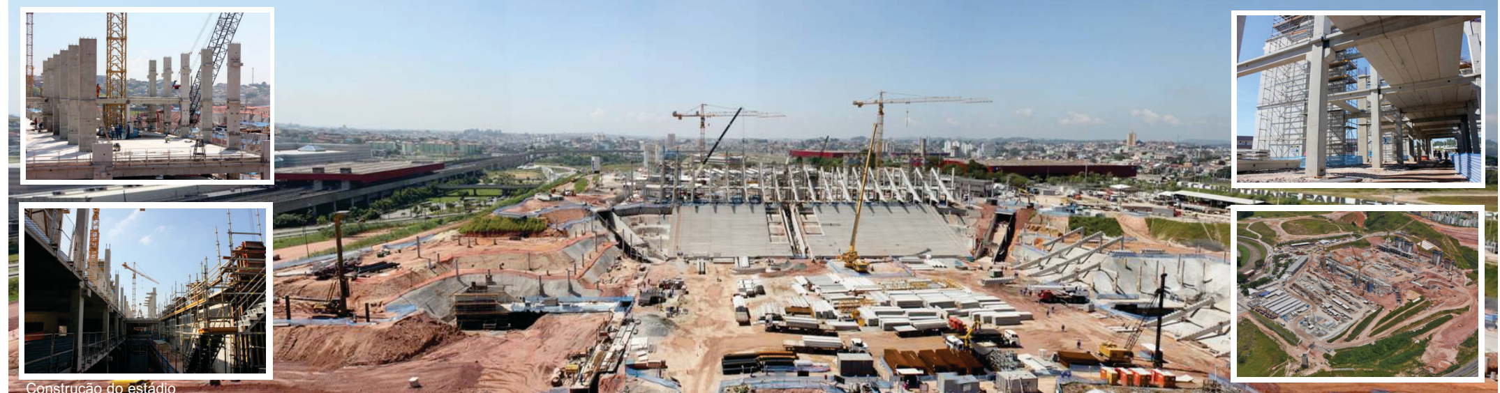
Construção do estádio
