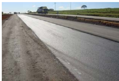
Duplicação BR101-RJ / Macaé – Campos (Autopista Fluminense)
