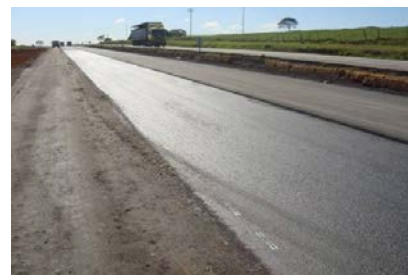
Duplicação BR101-RJ / Macaé - Campos (Autopista Fluminense)
