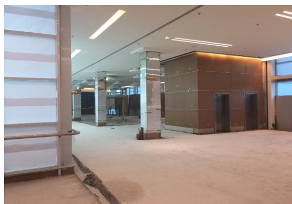
Centro Médico RibeirãoShopping em construção (mar/17)
