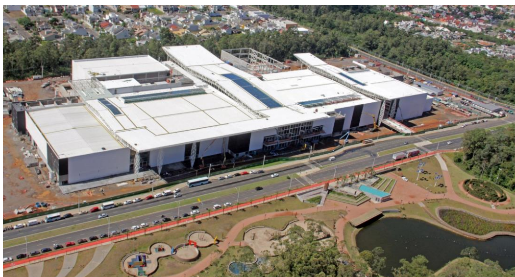
ParkShoppingCanoas em construção (abr/17)
