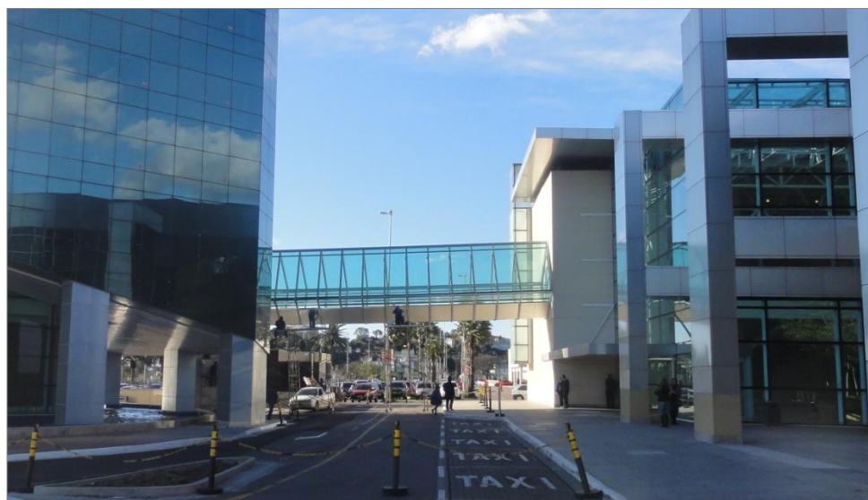
Passarela suspensa conectando a Cristal Tower ao BarraShoppingSul
