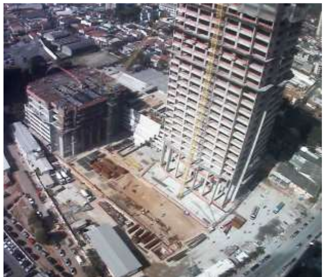
Foto do Canteiro de Obra EZTowers em 07 de agosto de 2013
