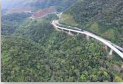
Duplicação da Serra do Cafezal (Autopista Régis Bittencourt)
