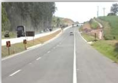
Duplicação BR101-RJ / Macaé – Campos (Autopista Fluminense)
