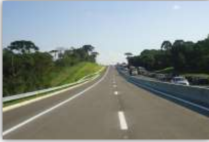
Duplicação da BR – 116/PR (Autopista Planalto Sul)
