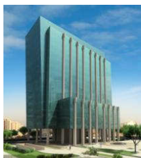
Edifício Faria Lima São Paulo/SP
