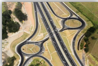
Duplicação BR101-RJ / Macaé – Campos (Autopista Fluminense)
