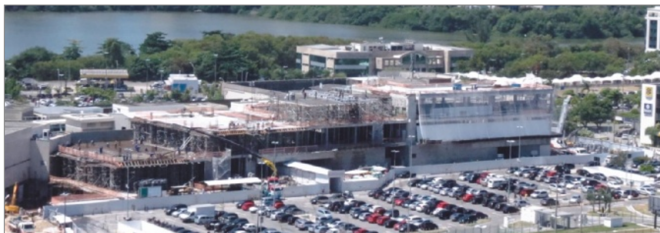
BarraShopping Expansão VII – obras (fevereiro 2014)
