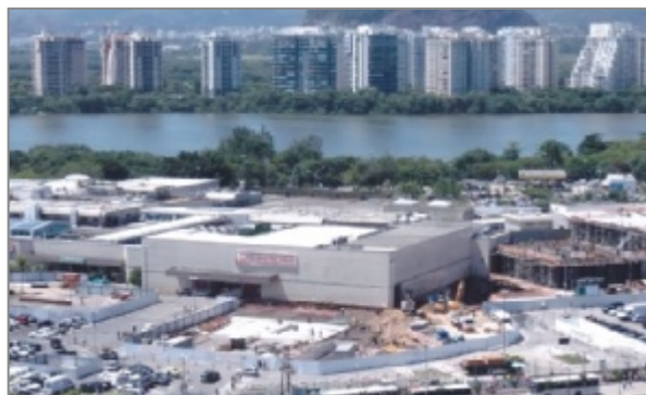
BarraShopping Expansão VII - obras (fevereiro 2014)
