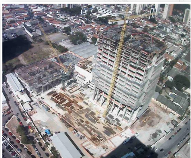
Foto do Canteiro de Obra EZTowers em 09 de maio de 2013
