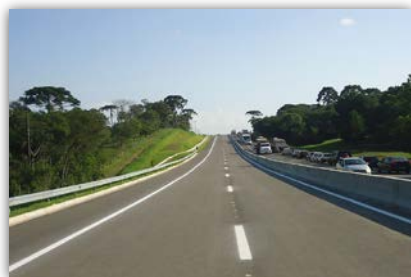
Duplicação da BR-116/PR (Autopista Planalto Sul)
