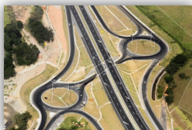
Duplicação BR101-RJ / Macaé – Campos (Autopista Fluminense)
