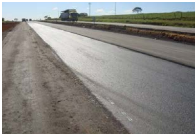
Duplicação BR101-RJ / Macaé – Campos (Autopista Fluminense)
