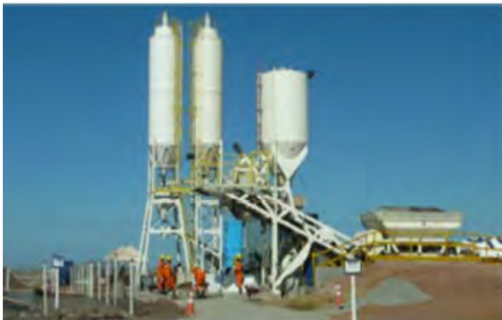
Montagem da central de concreto de 80m 3
