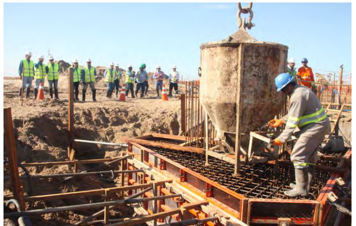
Fundações dos edifícios industriais
