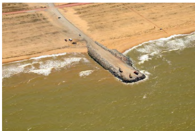
Enrocamento para proteção do canal de acesso à Unidade de Construção Naval do Açú
