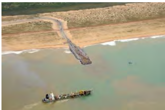
Enrocamento para proteção do canal de acesso à Unidade de Construção Naval do Açú
