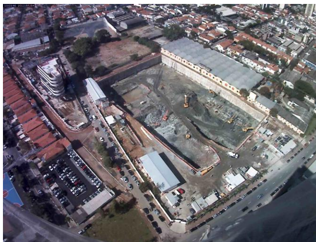
Obras EZ Tower - 04.05.2012
