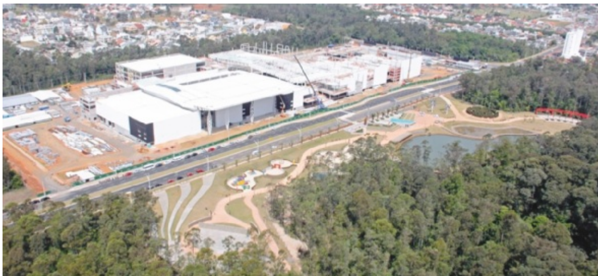
ParkShoppingCanoas em construção (Set/16)
