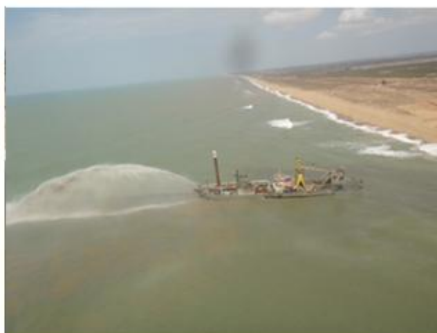
Obras de dragagem
