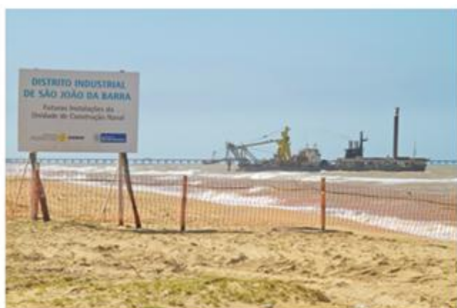
Obras de dragagem
