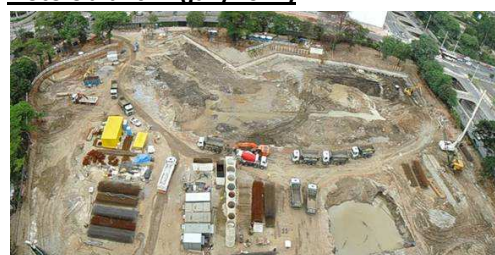
Foto obra “JK” (jan/2012)
