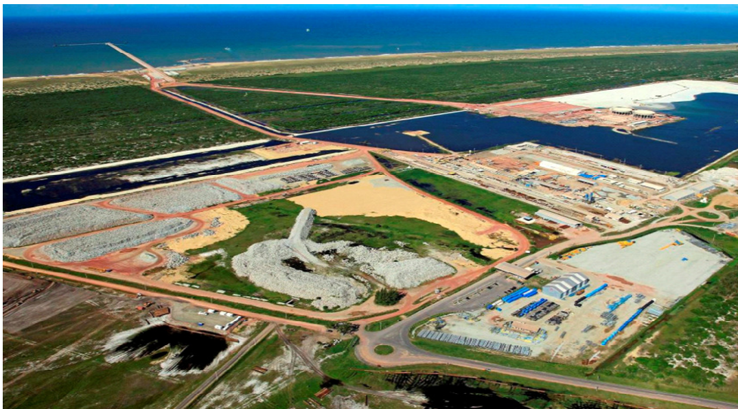
Vista geral da área LLX Minas-Rio no TX1
