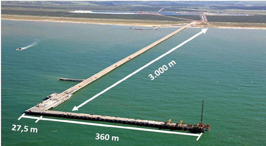
Vista geral ponte de acesso (TX1)
