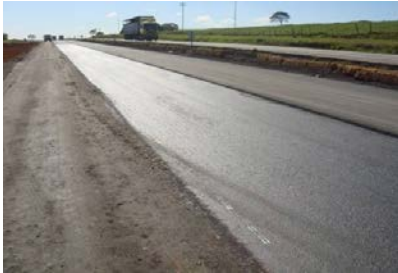
Duplicação BR101-RJ / Macaé – Campos (Autopista Fluminense)
