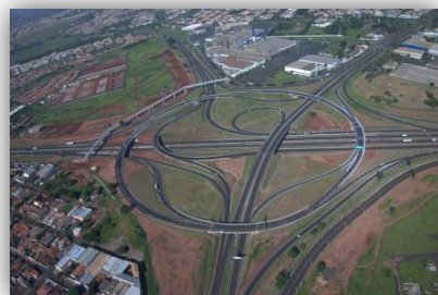
Dispositivo de acesso a Ribeirão Preto (Autovias e Vianorte)
