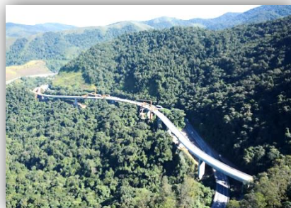
Duplicação da Serra do Cafezal (Autopista Régis Bittencourt)
