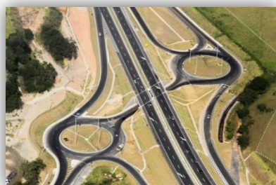
Duplicação BR101-RJ / Macaé – Campos (Autopista Fluminense)
