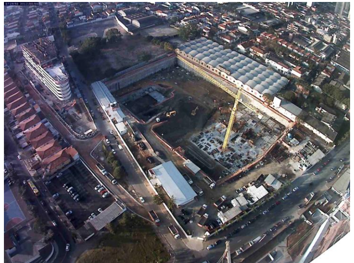
Foto do Canteiro de Obra EZTower dia 08 de Agosto de 2012
