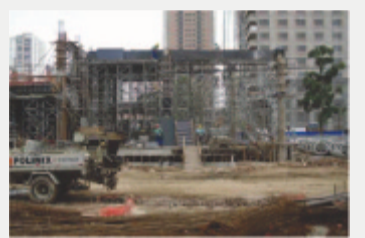
Obra de Expansão do Metrôpole
