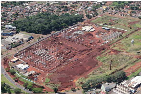
Obras do Projeto do Boulevard Londrina
