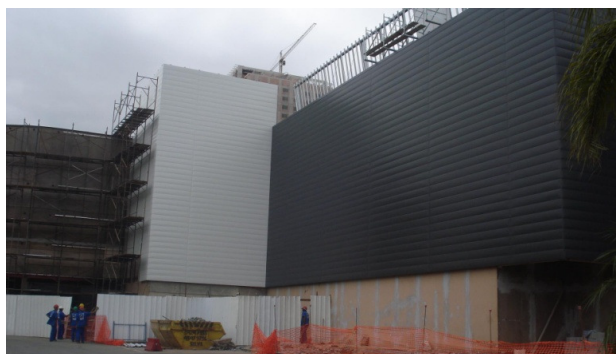
Obras de Expansão do Metrópole
