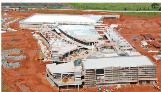
Obras do Uberlândia Shopping
