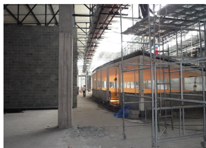
Obras de Expansão do Campo Limpo
