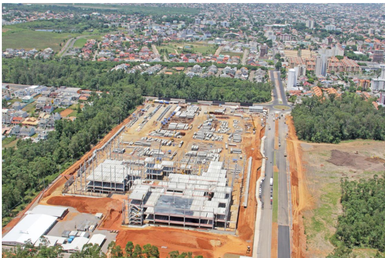
ParkShoppingCanoas em construção (Jan-16)
