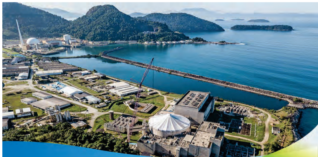
Vista da Central Nuclear Almirante Álvaro Alberto - CNAEA Usina de Angra 1, Angra 2 e Angra 3
