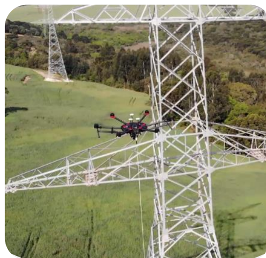
Uso de drone para lançamento dos cabos
