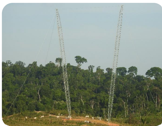
Montagem das torres
