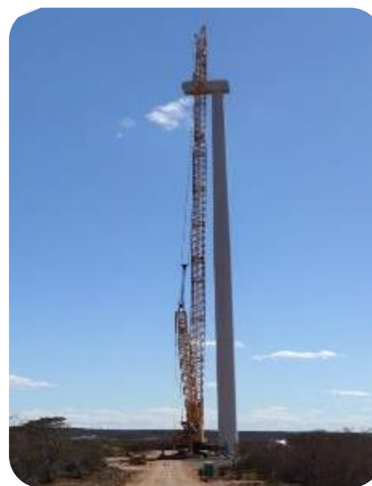
Montagem dos aerogeradores
