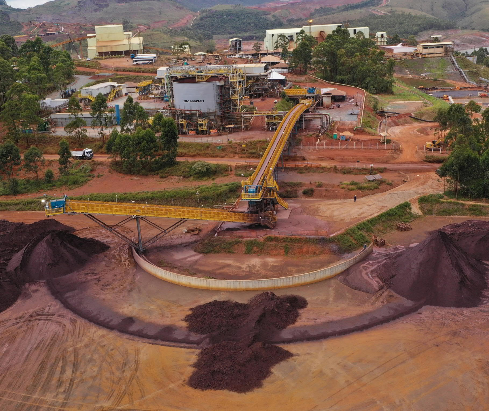
Planta de filtragem de rejeitos no complexo de Vargem Grande, entregue em março de 2021
