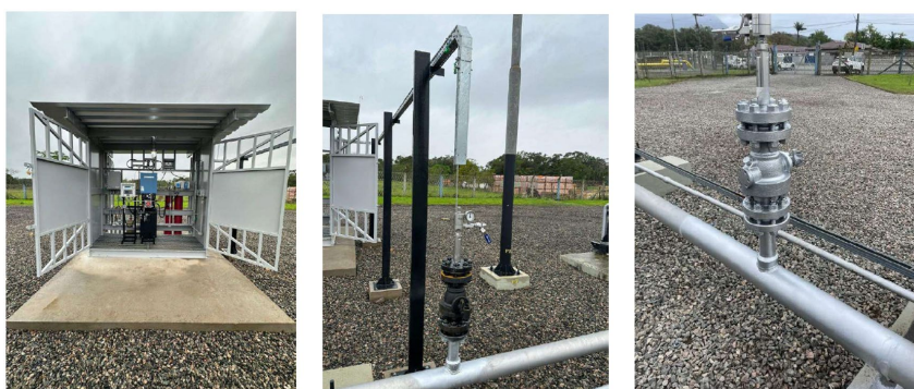
Figura 14 – Instalação do cromatógrafo de Joinville
