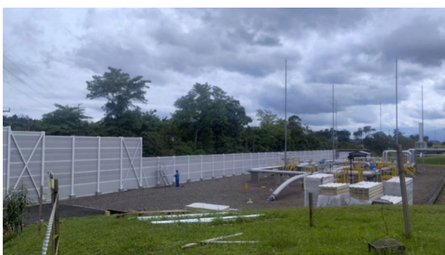
Figura 28 – Instalação da barreira acústica na Estação de Compressão de Siderópolis/SC
