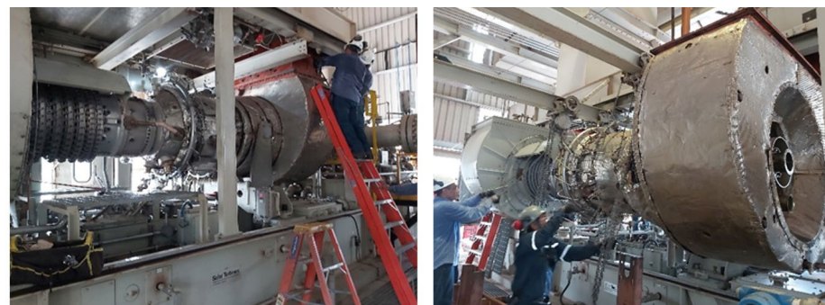
Figura 24 – Substituição da turbina A da Estação de Compressão de Corumbá/MS
