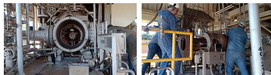
Figura 25 – Substituição do bundle do compressor da Estação de Compressão de Penápolis/SP
