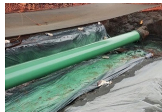
Figura 17 – Aplicação do revestimento na Estação de Compressão de Campo Grande/MS
