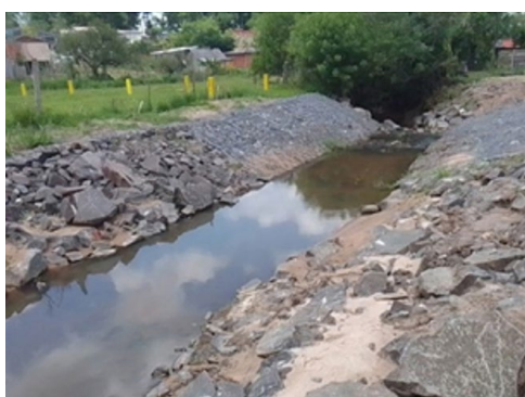
Figura 21 – Reparo de travessia de rio
