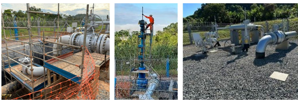
Figura 27 – Serviço de trepanação
